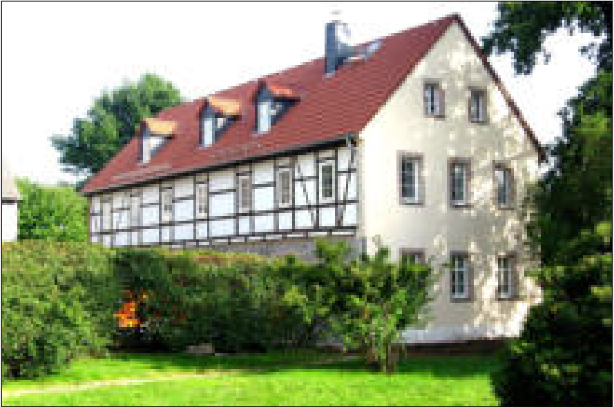
Das neue Haus, das den Namen „Hoffnung“ trägt.
