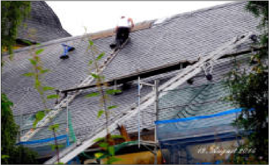
„Dachdecker Fischer“ aus Rossau bei der Arbeit
