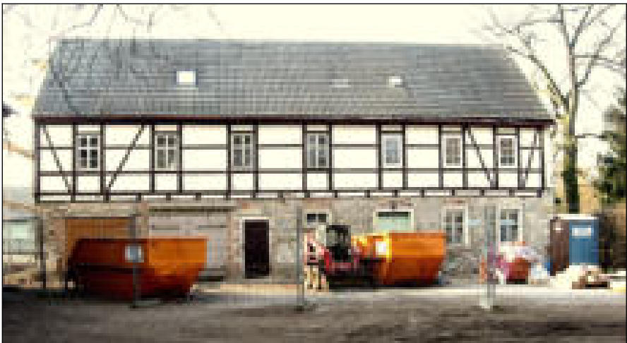
Das „Nebenhaus“: Beginn der Rekonstruktion im Jahre 2010
